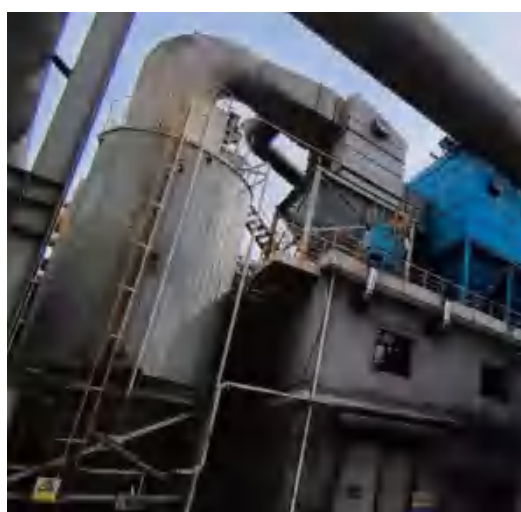
D 组干熄焦高活性钙粉 \text{Ca}(\text{OH})_2 直喷干法脱硫装置+布袋除尘器+30m 高排气筒
