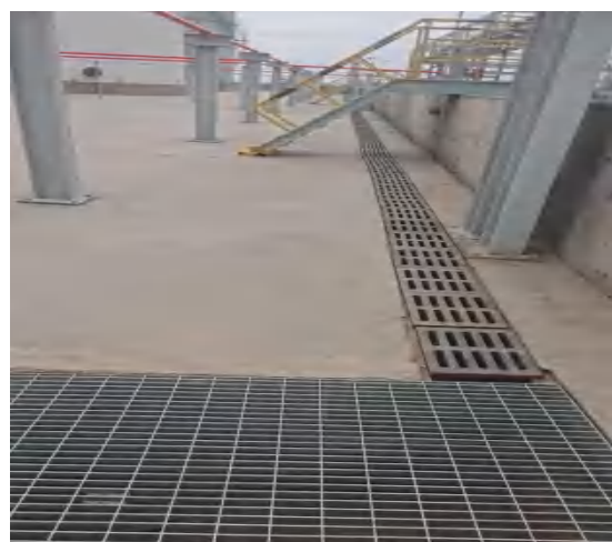
杂醇储罐围堰及其导流渠和积液池
