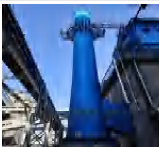
D101 焦转运站布袋除尘器+20m 高排气筒
