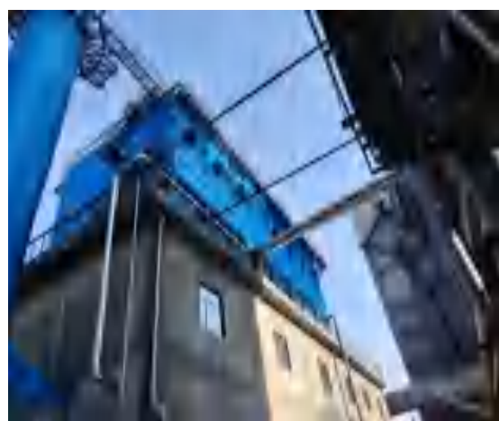
1#筛焦地面站布袋除尘器+30m 高排气筒
