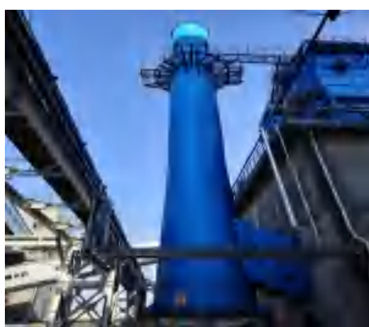
1#筛焦地面站布袋除尘器+30m 高排气筒
