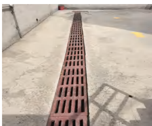
洗油储罐围堰及其导流渠和积液池
