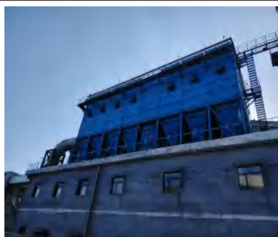
2#筛焦地面站布袋除尘器+30m 高排气筒
