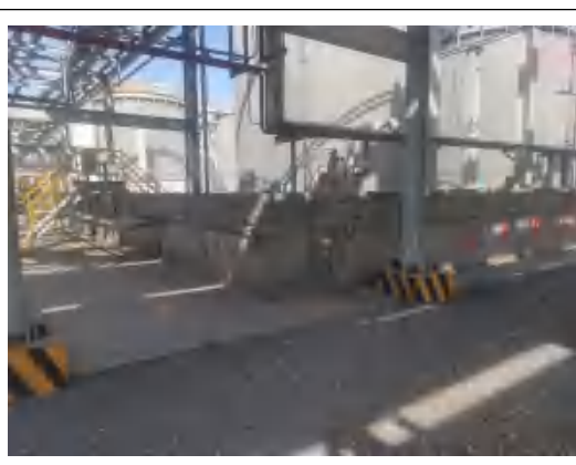
碱液储罐围堰及其导流渠和积液池
