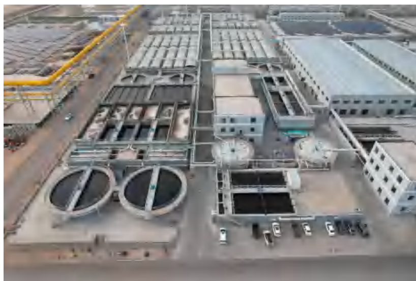
1 座 550\text{m}^3/\text{h} 的预处理+生化污水处理站
