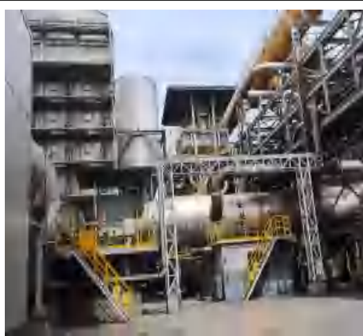
C 组捣固焦炉 \text{NaHCO}_3 干法脱硫装置+布袋除尘器+SCR 选择性催化还原脱硝+135m 高排气筒
