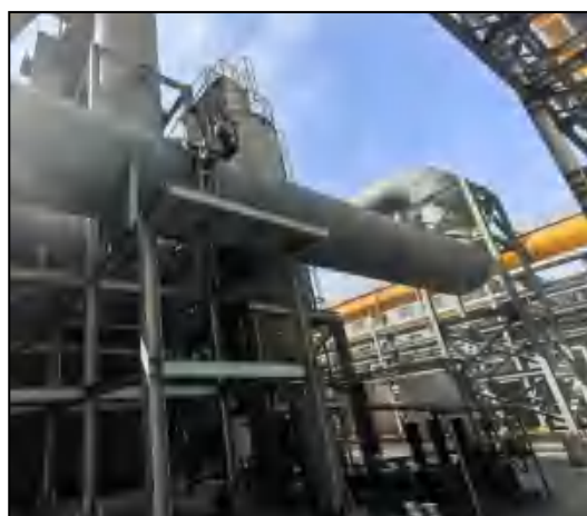
A 组干熄焦高活性钙粉 \text{Ca}(\text{OH})_2 直喷干法脱硫装置+布袋除尘器+30m 高排气筒
