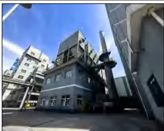
B 组干熄焦高活性钙粉 \text{Ca}(\text{OH})_2 直喷干法脱硫装置+布袋除尘器+30m 高排气筒
