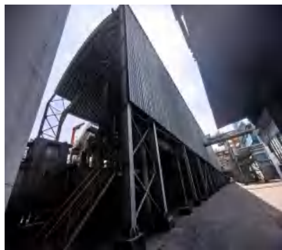
B 组焦侧空间封闭大棚+布袋除尘器
