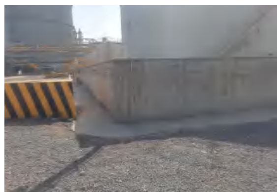
粗苯储罐围堰及其导流渠和积液池
