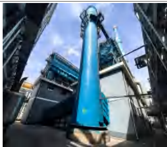
A 组、B 组推焦废气高活性钙粉 \text{Ca}(\text{OH})_2 直喷干法脱硫装置+布袋除尘器+30m 高排气筒
