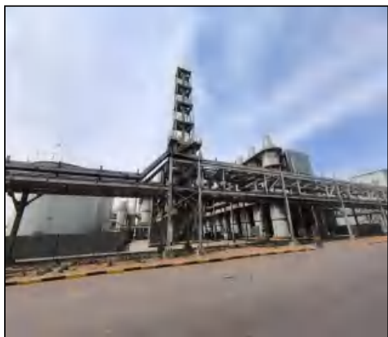
1 套两级洗涤塔+1 套电除雾器+1 个 40m 高排气筒
