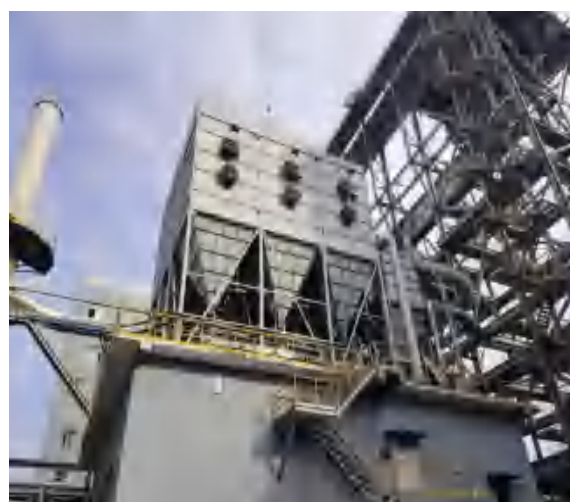
备用干熄焦地面站高活性钙粉 \text{Ca}(\text{OH})_2 直喷干法脱硫装置+布袋除尘器+30m 高排气筒
