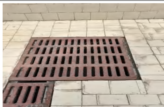
碱液储罐围堰及其导流渠和积液池
