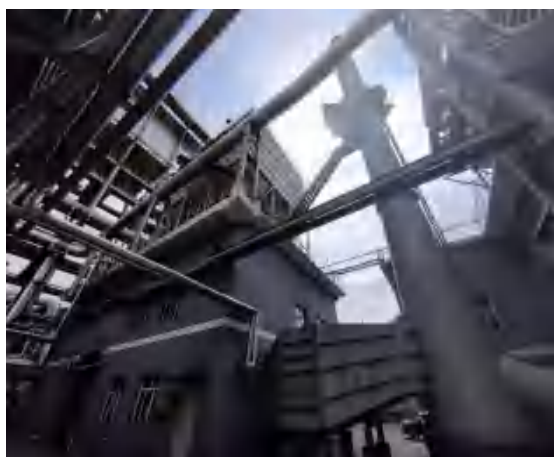
C 组干熄焦高活性钙粉 \text{Ca}(\text{OH})_2 直喷干法脱硫装置+布袋除尘器+30m 高排气筒
