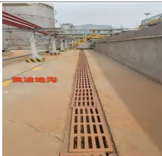
煤焦油储罐围堰及其导流渠和积液池
