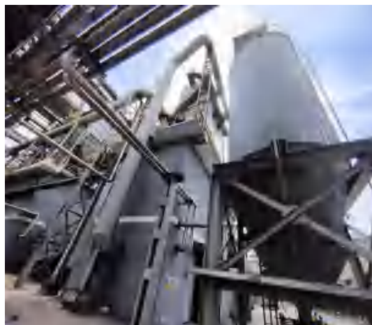
C 组干熄焦高活性钙粉 \text{Ca}(\text{OH})_2 直喷干法脱硫装置+布袋除尘器+30m 高排气筒
