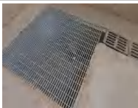
甲醇储罐围堰及其导流渠和积液池
