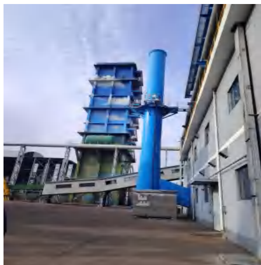
A 组捣固焦炉装煤地面除尘站焦炭过滤+布袋除尘器+30m 高排气筒
