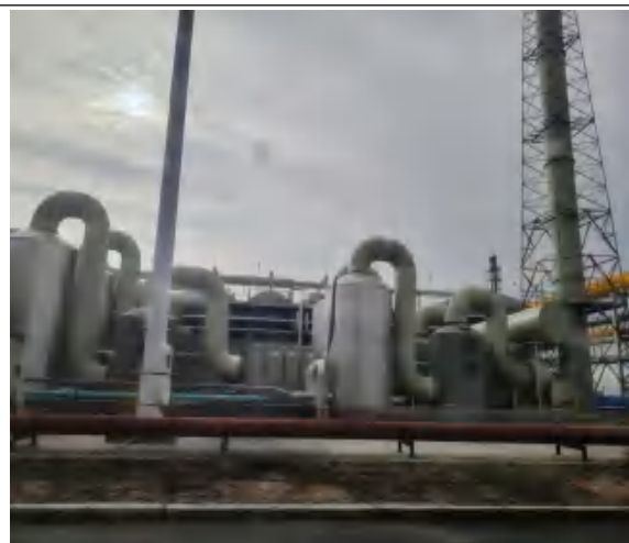
加盖密闭+1 套生物除臭设施+1 个 30m 高排气筒
