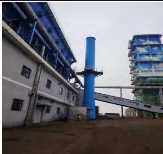
D 组捣固焦炉装煤地面除尘站焦炭过滤+布袋除尘器+30m 高排气筒
