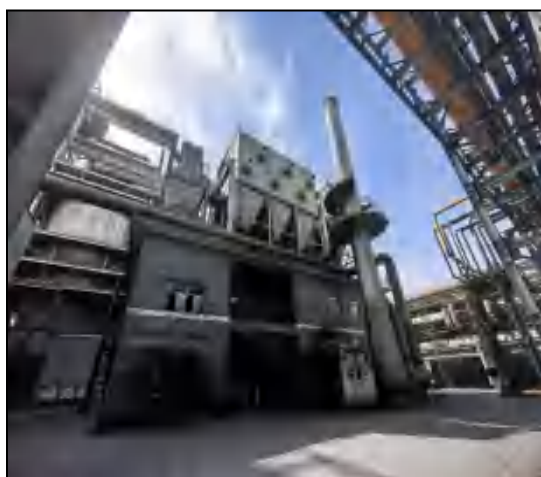
A 组干熄焦高活性钙粉 \text{Ca}(\text{OH})_2 直喷干法脱硫装置+布袋除尘器+30m 高排气筒
