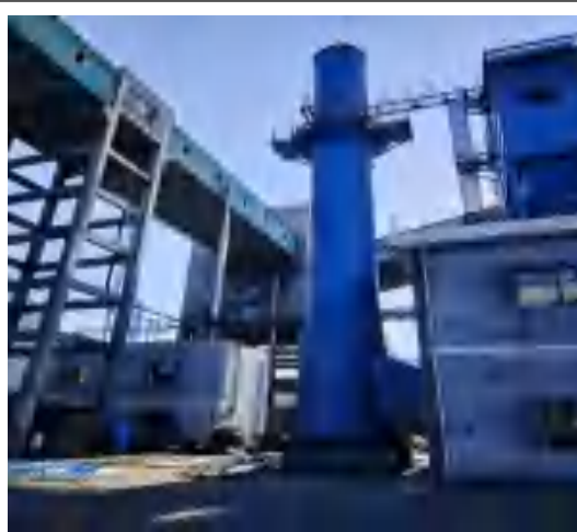
2#筛焦地面站布袋除尘器+30m 高排气筒
