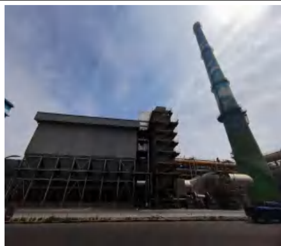
C 组捣固焦炉 \text{NaHCO}_3 干法脱硫装置+布袋除尘器+SCR 选择性催化还原脱硝+135m 高排气筒
