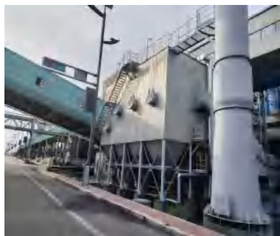
835E 焦转运站布袋除尘器+20m 高排气筒
