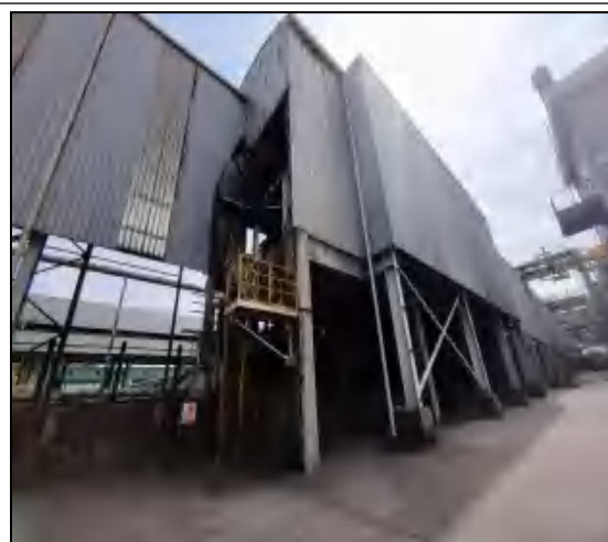
C 组焦侧空间封闭大棚+布袋除尘器
