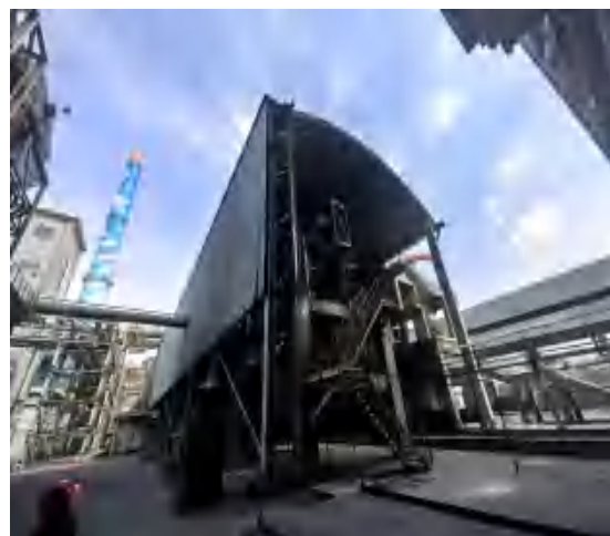
A 组焦侧空间封闭大棚+布袋除尘器
