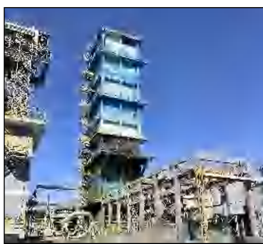
备用湿熄焦双层钢结构捕尘+水雾捕集装置+65m 高湿熄焦塔。
