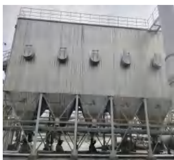
835G 焦转运站布袋除尘器+20m 高排气筒
