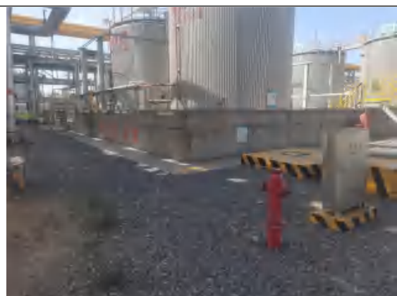
碱液储罐围堰及其导流渠和积液池
