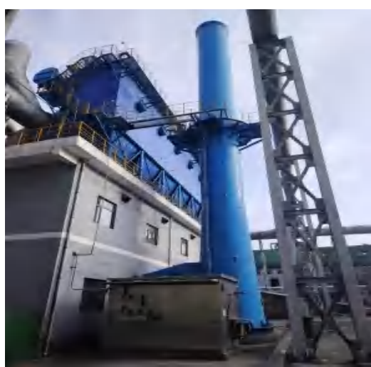
C 组捣固焦炉装煤地面除尘站焦炭过滤+布袋除尘器+30m 高排气筒
