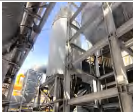
B 组干熄焦高活性钙粉 \text{Ca}(\text{OH})_2 直喷干法脱硫装置+布袋除尘器+30m 高排气筒
