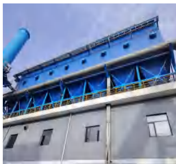
A 组捣固焦炉装煤地面除尘站焦炭过滤+布袋除尘器+30m 高排气筒
