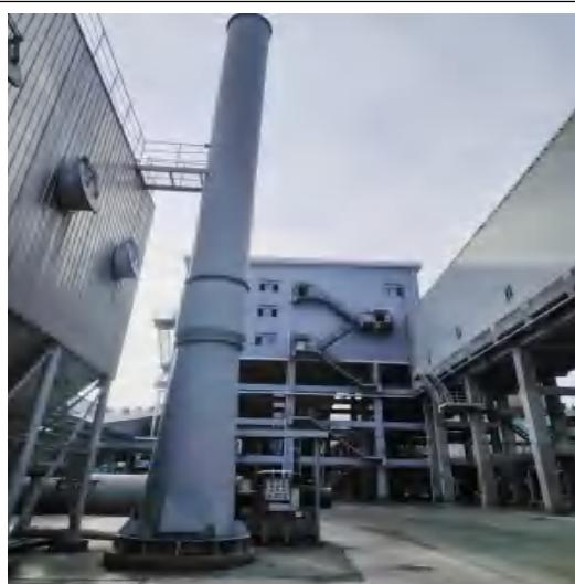
835G 焦转运站布袋除尘器+20m 高排气筒
