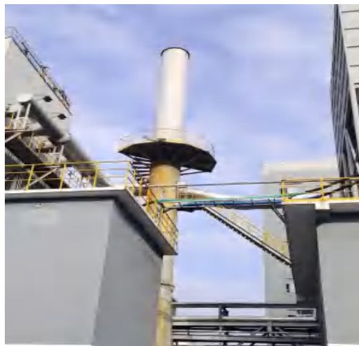
备用干熄焦地面站高活性钙粉 \text{Ca}(\text{OH})_2 直喷干法脱硫装置+布袋除尘器+30m 高排气筒
