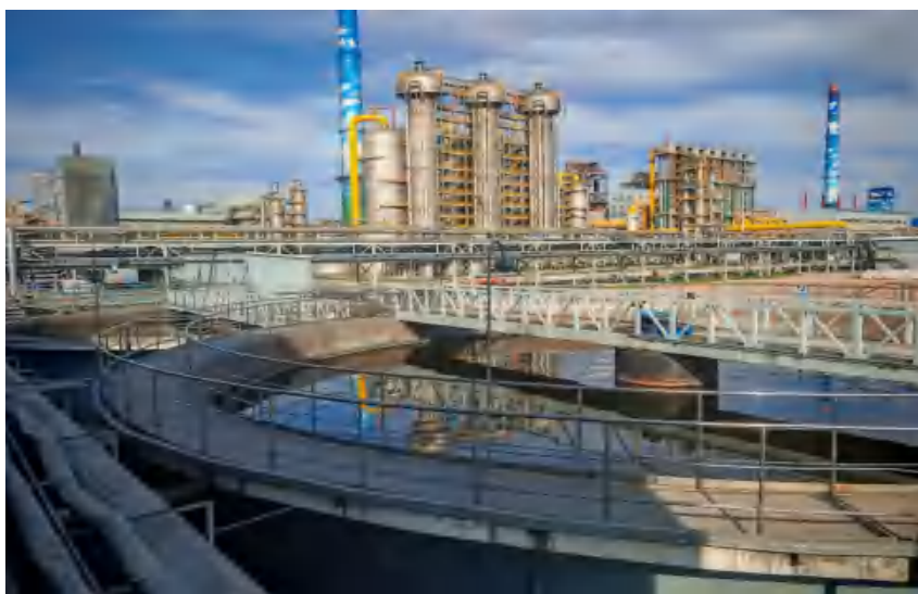
新建 1 套 600m 3 /h 熄焦水处理系统
