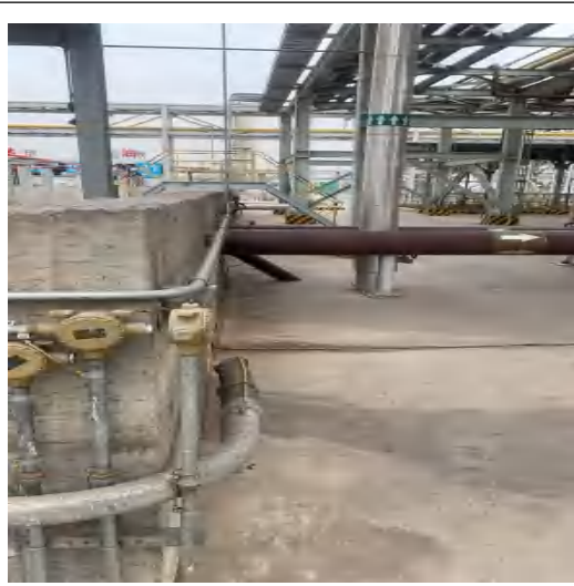
甲醇储罐围堰及其导流渠和积液池
