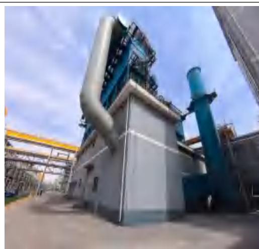
A 组、B 组推焦废气高活性钙粉 \text{Ca}(\text{OH})_2 直喷干法脱硫装置+布袋除尘器+30m 高排气筒
