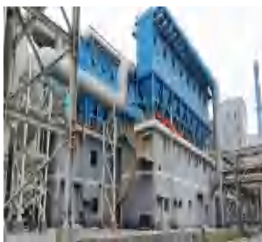
A 组焦侧空间封闭大棚+布袋除尘器
