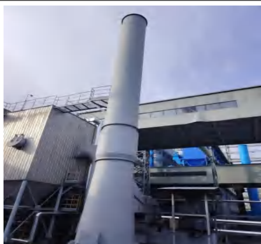
835E 焦转运站布袋除尘器+20m 高排气筒
