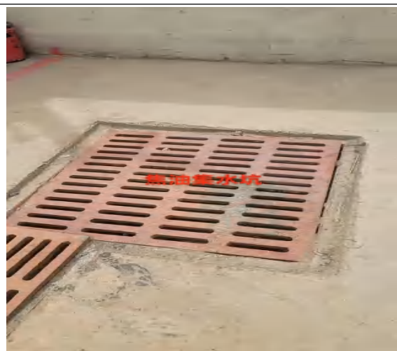
煤焦油储罐围堰及其导流渠和积液池
