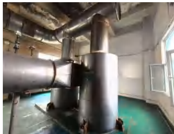
1#硫铵系统旋风除尘器+洗净塔除尘装置
