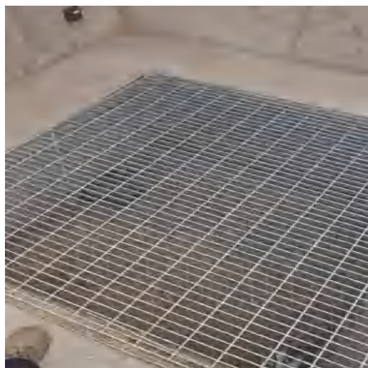
杂醇储罐围堰及其导流渠和积液池
