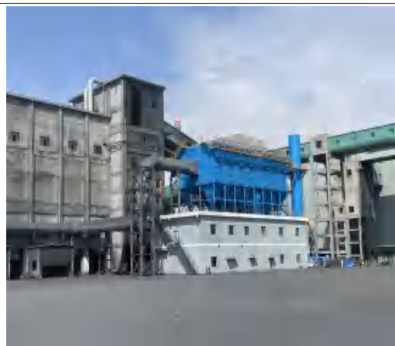
D301 焦转运站布袋除尘器+20m 高排气筒
