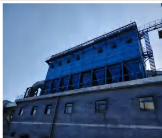
D101 焦转运站布袋除尘器+20m 高排气筒
