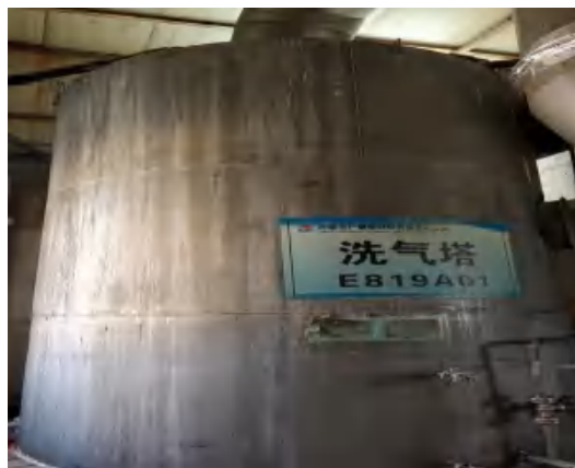
1#硫铵系统旋风除尘器+洗净塔除尘装置
