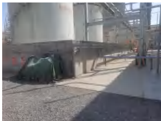
粗苯储罐围堰及其导流渠和积液池
