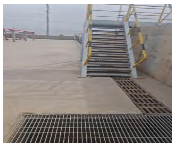
粗甲醇储罐围堰及其导流渠和积液池
