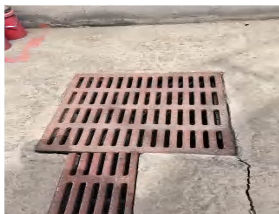
洗油储罐围堰及其导流渠和积液池
