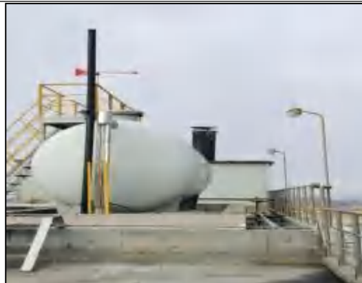
2#硫铵系统 25m 高排气筒
