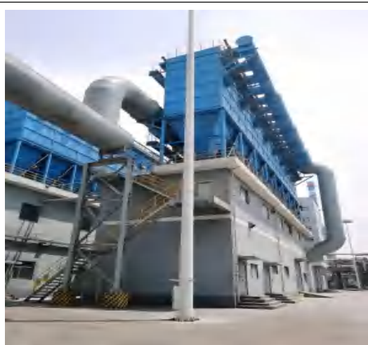
C 组焦侧空间封闭大棚+布袋除尘器
