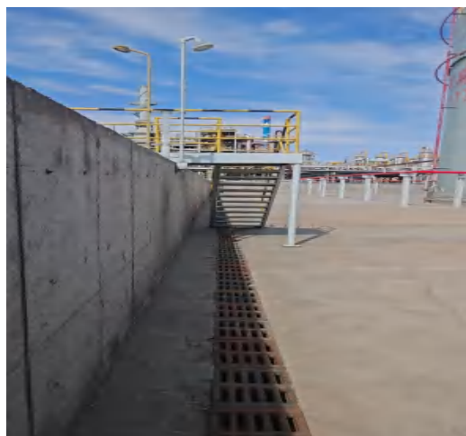
杂醇储罐围堰及其导流渠和积液池
