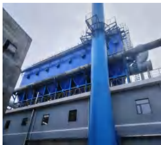
B 组捣固焦炉装煤地面除尘站焦炭过滤+布袋除尘器+30m 高排气筒
