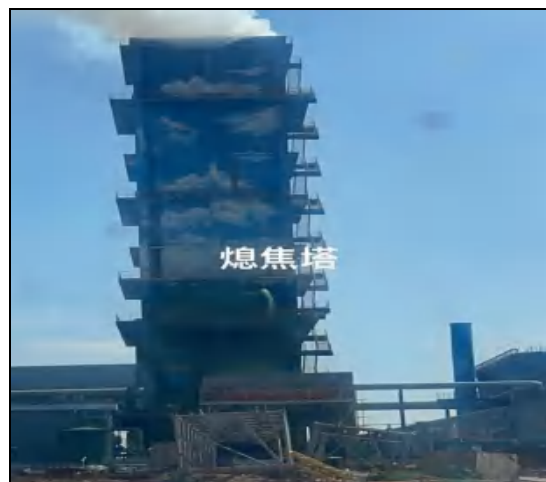
备用湿熄焦双层钢结构捕尘+水雾捕集装置+65m 高湿熄焦塔。
