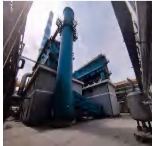
C 组、D 组推焦废气高活性钙粉 \text{Ca}(\text{OH})_2 直喷干法脱硫装置+布袋除尘器+30m 高排气筒
