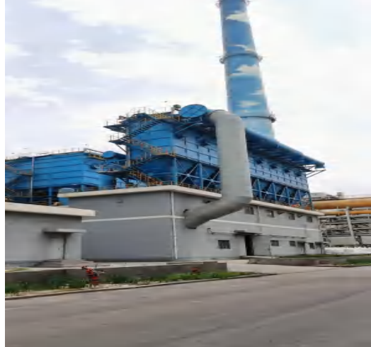
B 组焦侧空间封闭大棚+布袋除尘器
