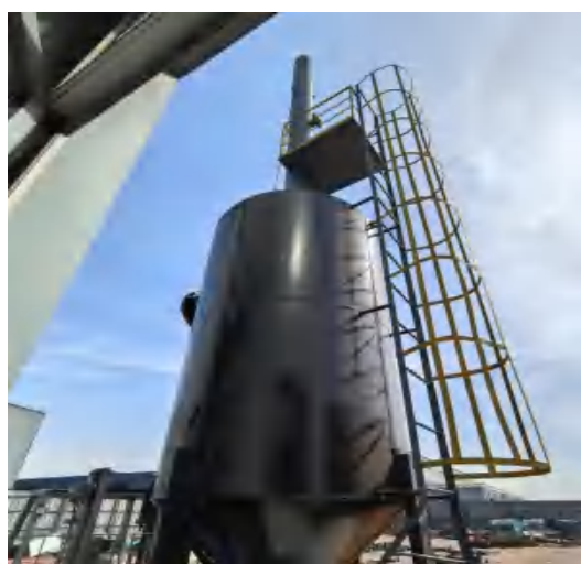
1 套活性炭吸附装置+1 个 15m 高的排气筒
