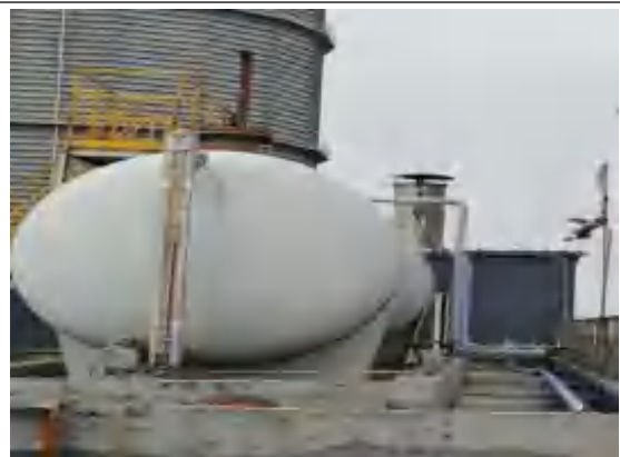
1#硫铵系统 25m 高排气筒
