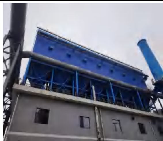
D 组捣固焦炉装煤地面除尘站焦炭过滤+布袋除尘器+30m 高排气筒
