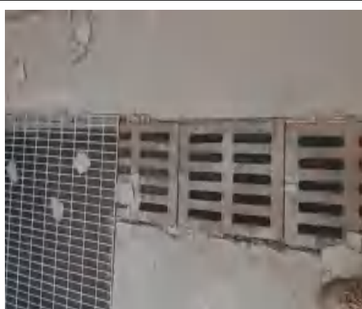
甲醇储罐围堰及其导流渠和积液池
