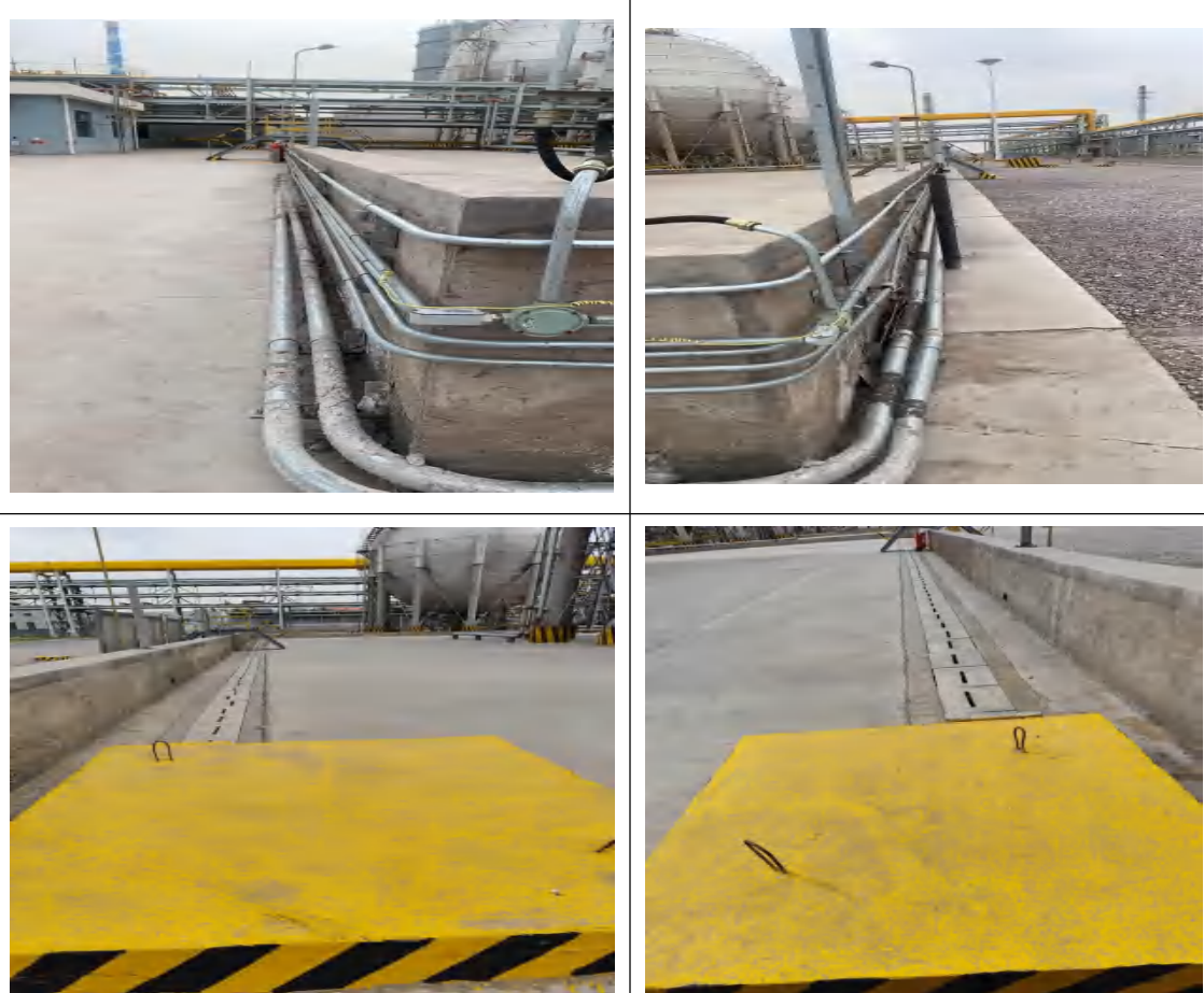
液氨储罐围堰及其导流渠和积液池
