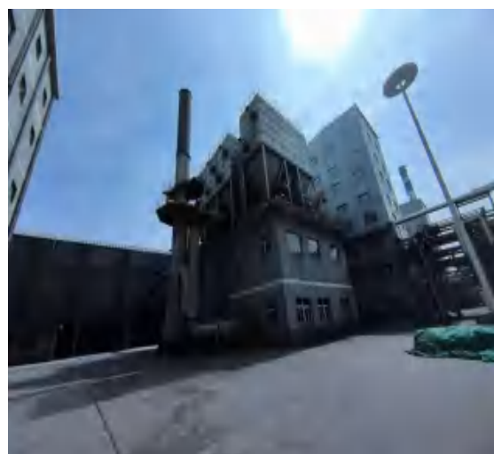
D 组干熄焦高活性钙粉 \text{Ca}(\text{OH})_2 直喷干法脱硫装置+布袋除尘器+30m 高排气筒
