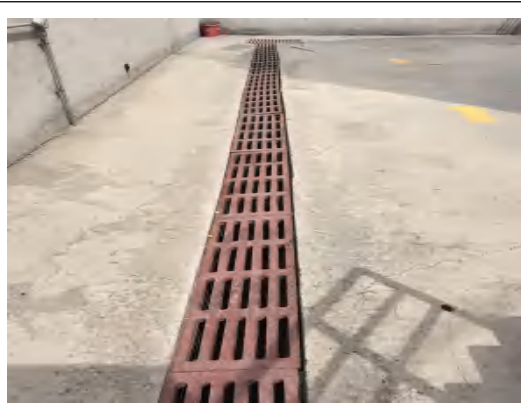
硫酸储罐围堰及其导流渠和积液池
