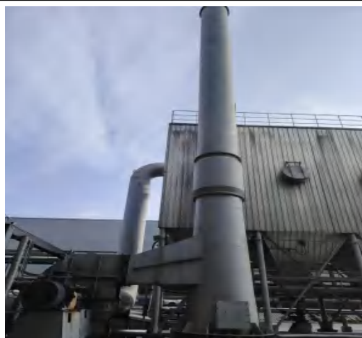
835B 焦转运站布袋除尘器+20m 高排气筒
