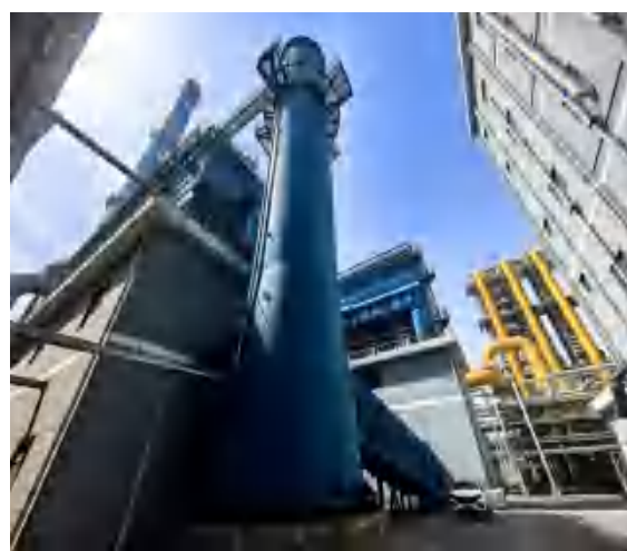
C 组、D 组推焦废气高活性钙粉 \text{Ca}(\text{OH})_2 直喷干法脱硫装置+布袋除尘器+30m 高排气筒
