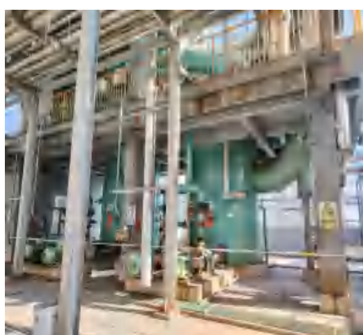
1 套两级洗涤塔+1 套电除雾器+1 个 40m 高排气筒
