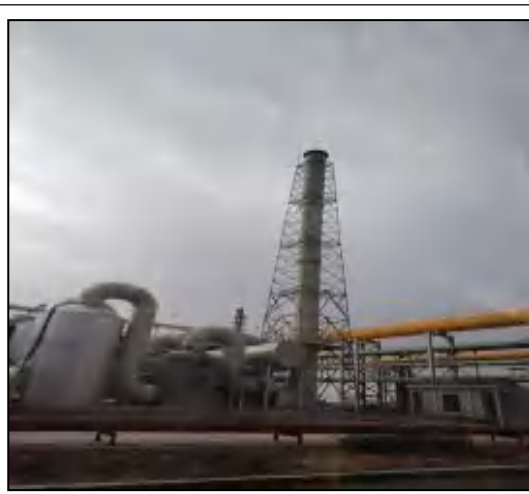
加盖密闭+1 套生物除臭设施+1 个 30m 高排气筒
