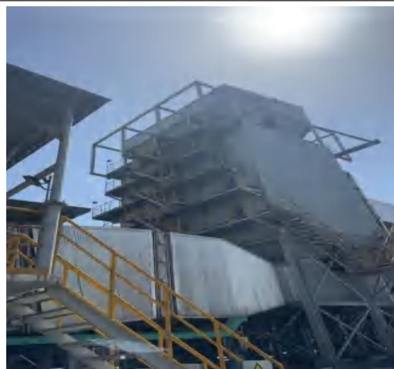
D 组捣固焦炉 \text{NaHCO}_3 干法脱硫装置+布袋除尘器+SCR 选择性催化还原脱硝+135m 高排气筒
