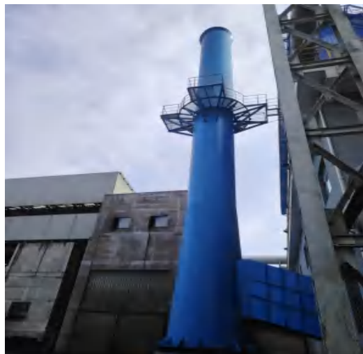
B 组捣固焦炉装煤地面除尘站焦炭过滤+布袋除尘器+30m 高排气筒
