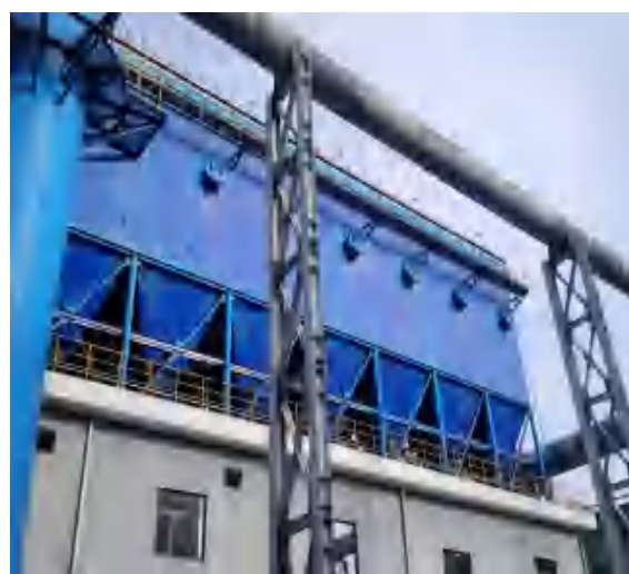
C 组捣固焦炉装煤地面除尘站焦炭过滤+布袋除尘器+30m 高排气筒
