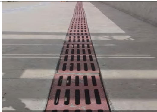
粗苯储罐围堰及其导流渠和积液池
