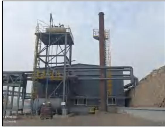
导热油炉低氮燃烧器+15m 高烟囱
